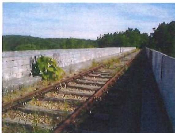
La voie sur le viaduc [EB-18]
