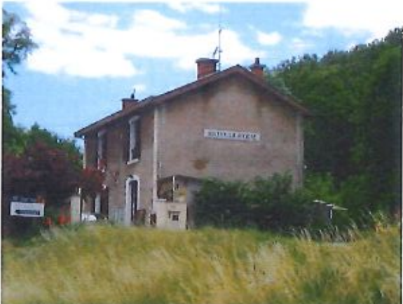
Ancienne station de Boissy-la-Rivière, situé en fait sur la commune de Saint-Cyr-la-Rivière [EB-01]
