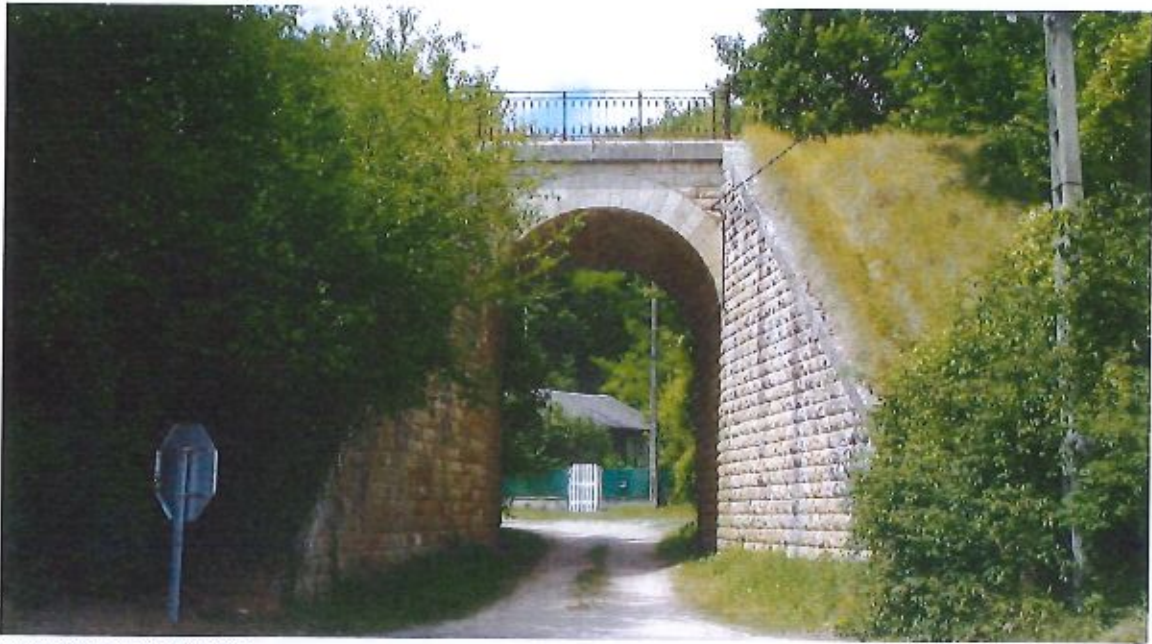
Pont cintré de Vauvert [EB-10]
