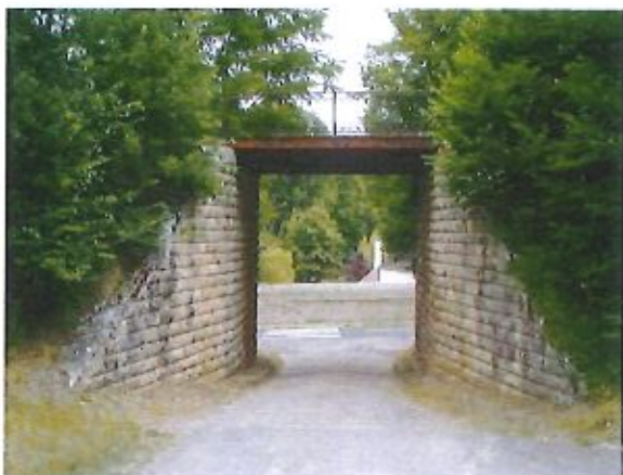
Pont sur le chemin du Montoir de la Tête de Chat [EB-08]
