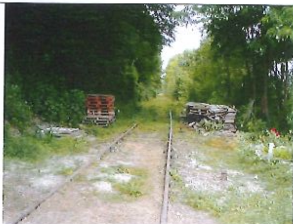
Près de la station de Boissy [EB-02]
