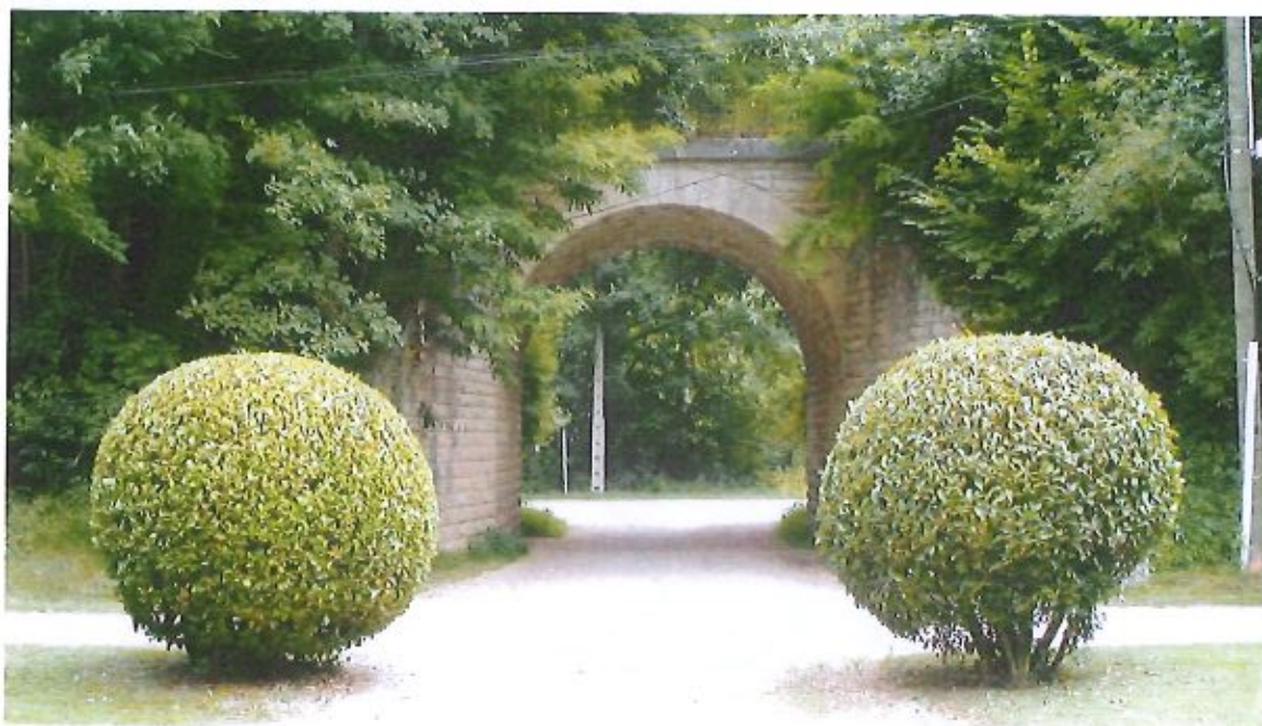
Pont cintré sur le chemin du Mesnil [EB-09]
