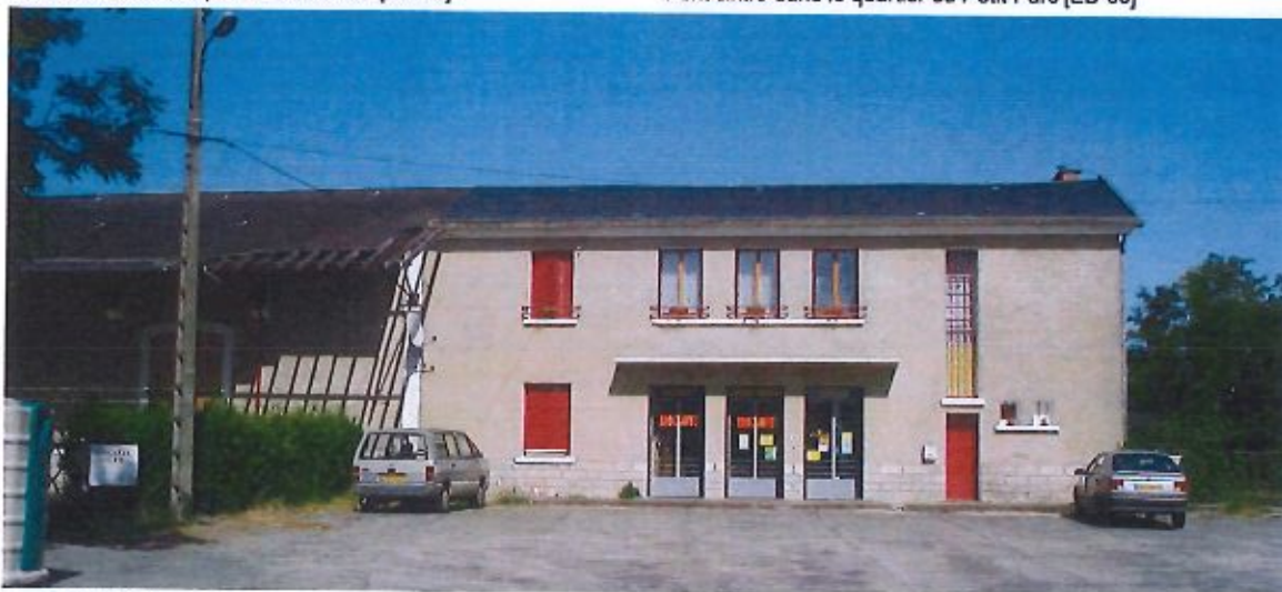
Gare de Méréville transformée en brocante [EB-04]
