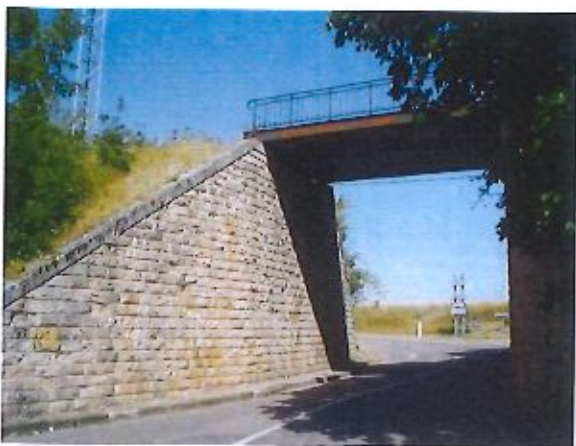
Pont à tablier métallique sur la RD 145 [EB-06]
