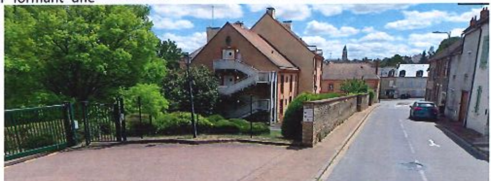
5 Côté pair, la rue de la Madame implique une attention particulière à porter au pignon du bâtiment
