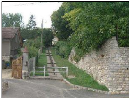
Escalier vers Renonval bordé par les seuls vestiges de remparts subsistants
