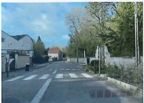
Bâtiment artisanal dont la mutation est à surveiller
