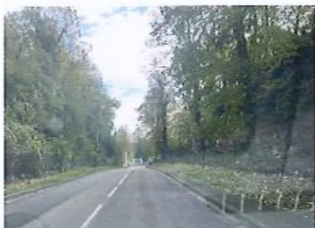
1 Entrée ouest principale, passage graduel du paysage rural au paysage villageois Forte présence végétale Environnement préservé
