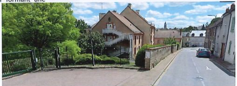
5 Côté pair, la rue de la Madame implique une attention particulière à porter au pignon du bâtiment
